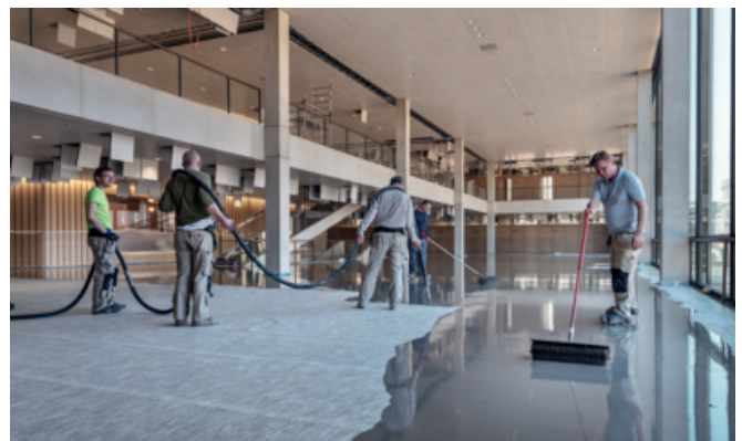
Egaliseren van de UZIN RR 201 met behulp van pomptechniek met UZIN NC 170 LevelStar.
