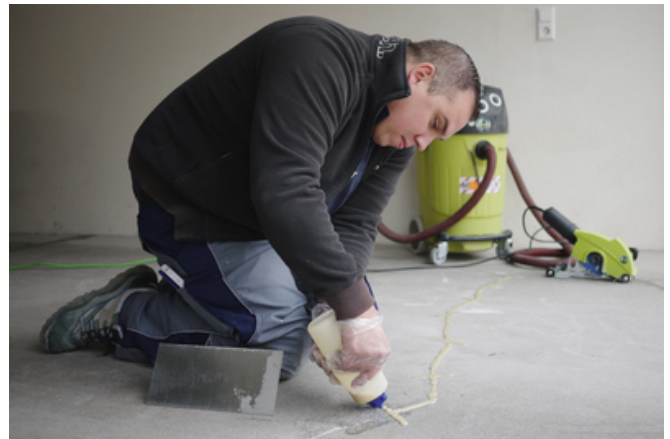
Na het uitfrezen, opzuigen en inleggen van de verankeringskrammen wordt de UZIN KR 516 in de voegen aangebracht.
