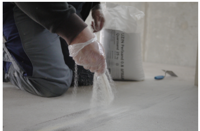
Gladgestreken UZIN KR 516 in verse toestand met UZIN kwartzand midden (0,4 – 0,8) instrooien.
